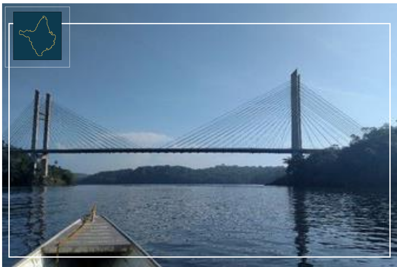
Ponte Binacional Franco-Brasileira. Fonte: DNIT.
